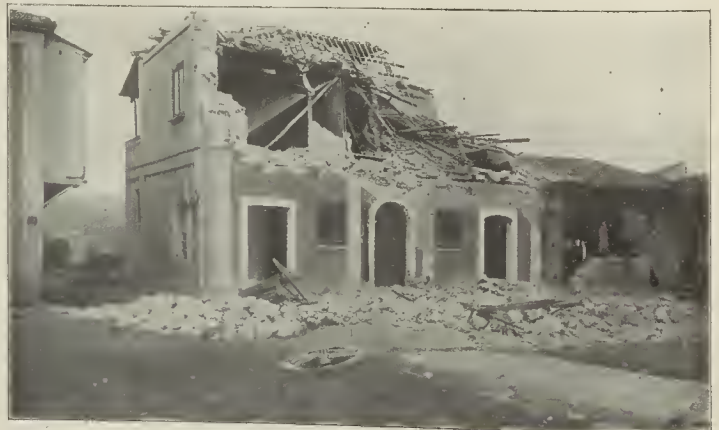
Reggio.—El edificio del Banco después del terremoto. (De fotografía de World's Graphic Press. París.)
